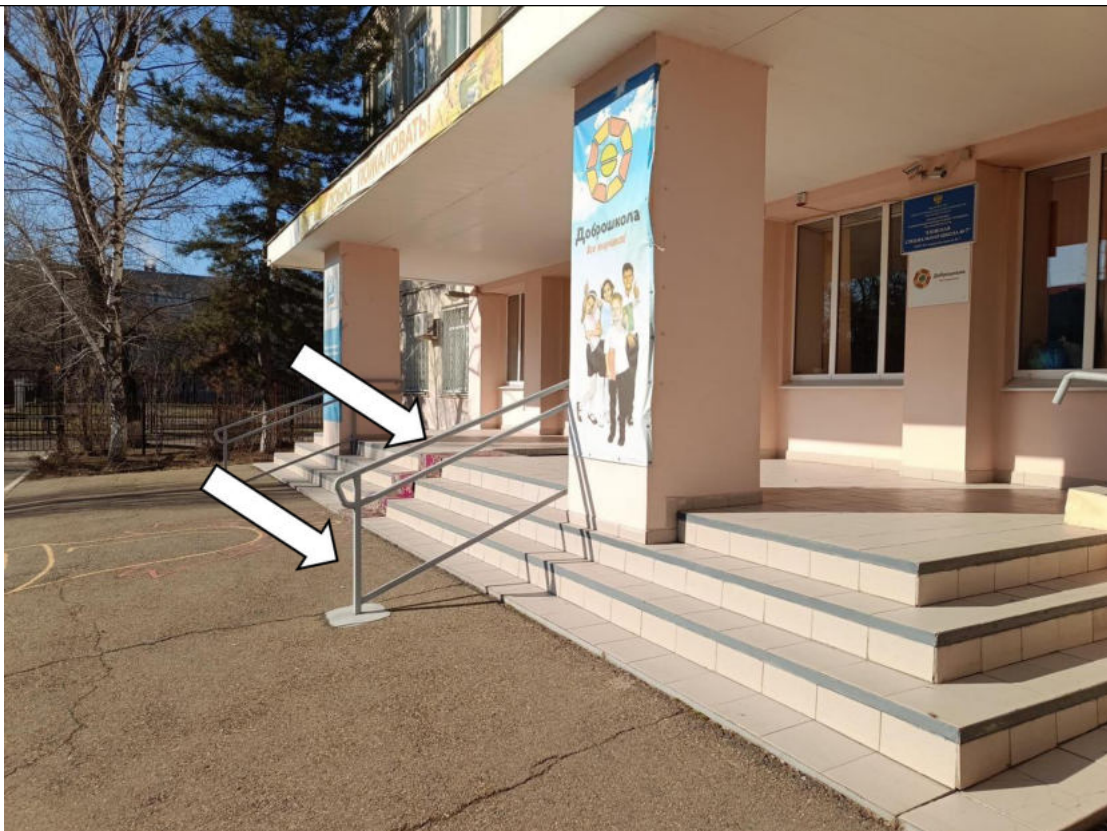
Фото № 5. Учебный корпус. Поручни на лестнице не соответствуют требованиям нормативной документации. Перед лестницей нет тактильной предупредительной разметки. Ступени контрастно не маркированы
