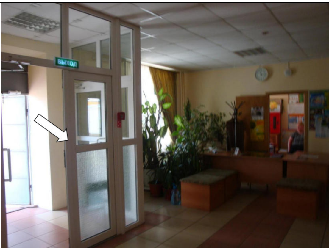
Фото № 11 Тамбур в жилом корпусе. Дверной проем и дверная ручка контрастно не маркированы
