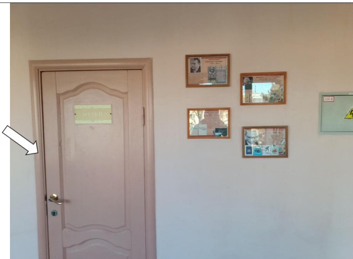
Фото № 21. Дверь в кабинет. Дверной проем и дверная ручка контрастно не маркированы. Информационная табличка расположена на дверном полотне.
