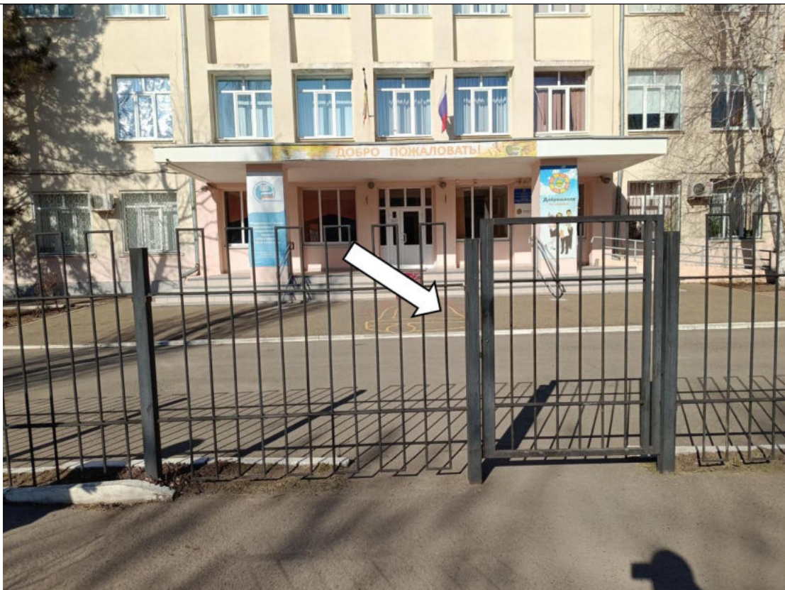
Фото № 1. Вход на территорию. Нет таблички об объекте.
