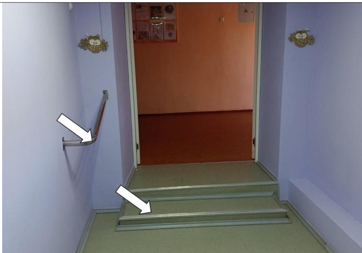
Фото № 16. Лестница по пути движения. Ступени контрастно не маркированы. Поручень с одной стороны лестницы
