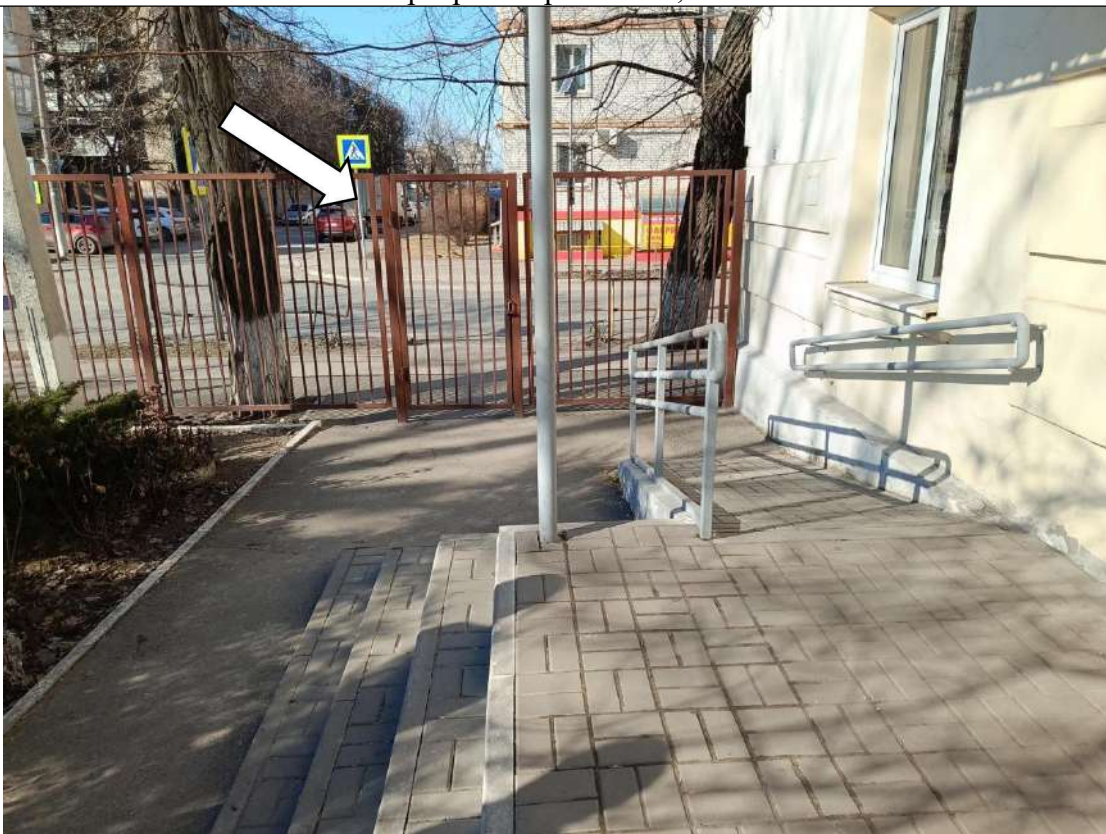
Фото № 1. Проем калитки контрастно не маркирован. Нет таблички об объекте.
