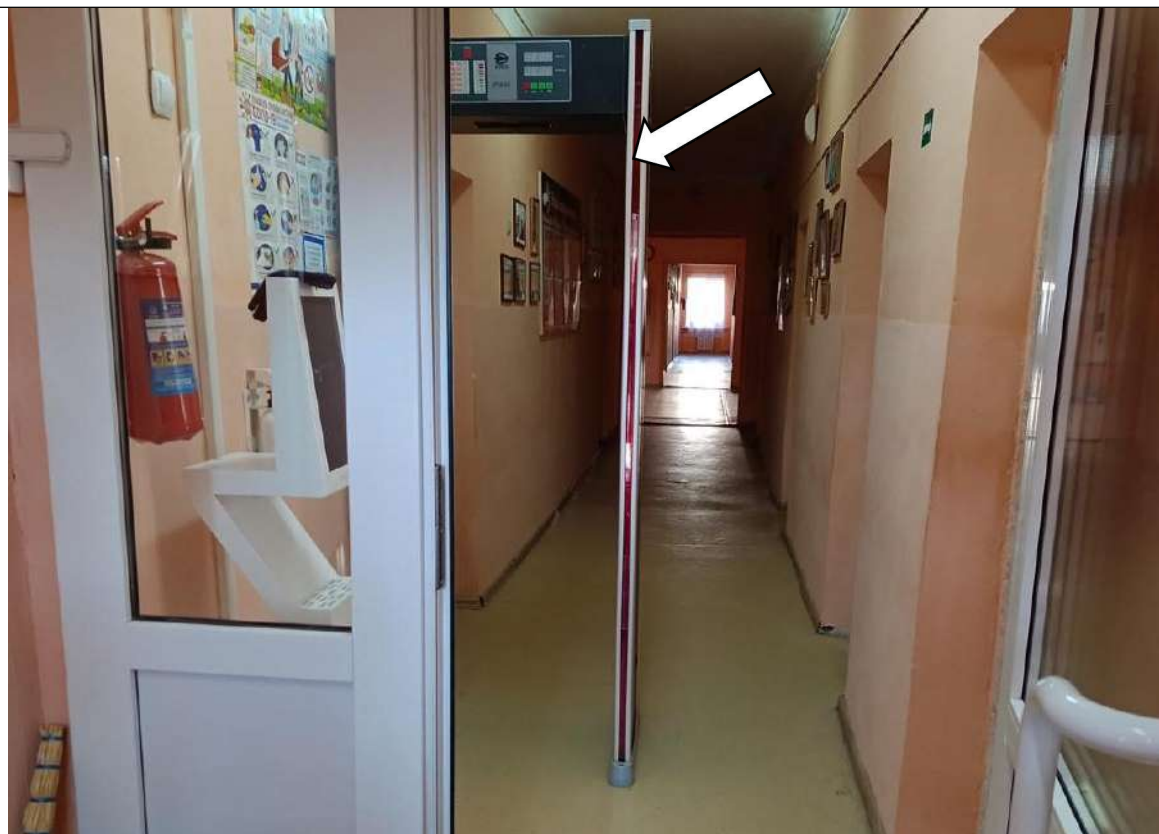
Фото № 8. Контрольно-пропускное устройство с шириной проема 0,7м
