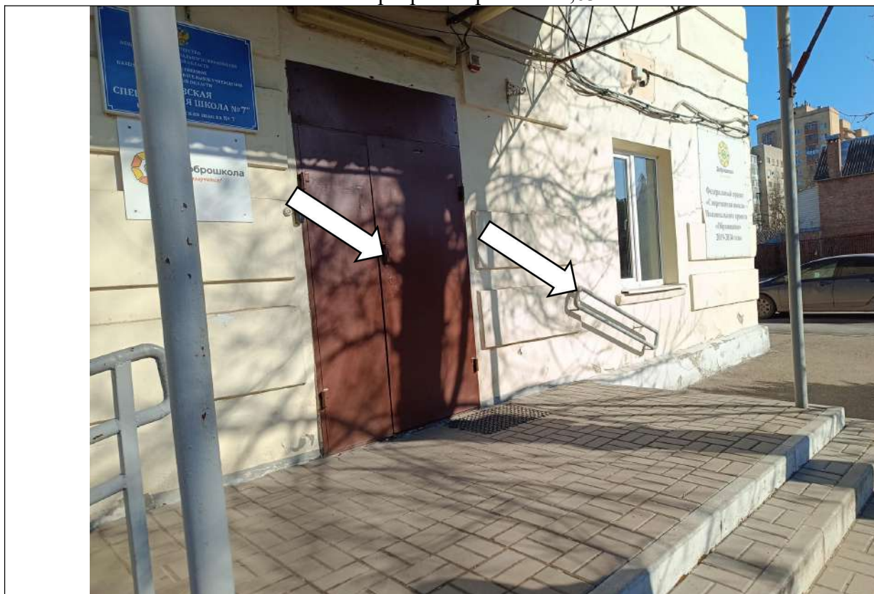
Фото № 5. Поручень на лестнице не соответствуют требованиям нормативной документации. Дверная ручка не контрастна
