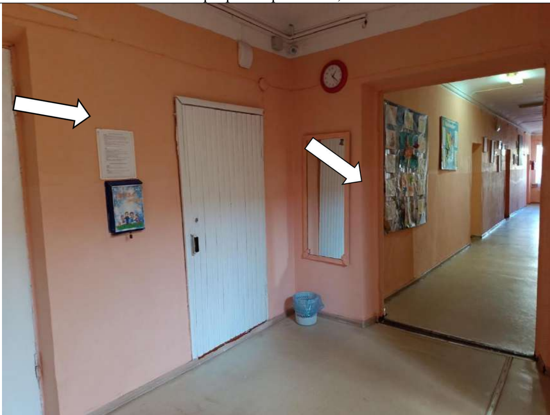
Фото № 9. Нет указателей направления движения. Проем по пути движения контрастно не маркирован
