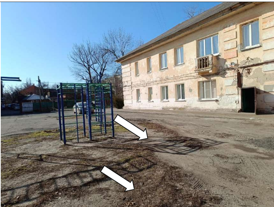
Фото № 2. Поверхность покрытия по путям движения по территории имеет неровности, частично грунтовое
